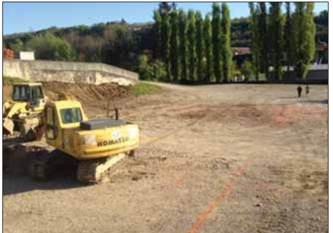
Le chantier a démarré sur le parking Cartallier.
