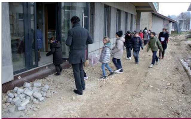
La découverte de l'avancée des travaux du restaurant scolaire...
