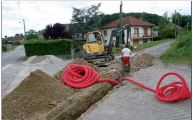
Lors des travaux d'enfouissement
