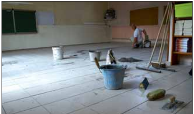
Le carrelage a été installé dans les classes
