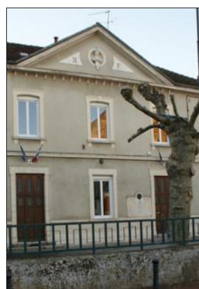
Dans le projet de modification du bâtiment de la mairie, des caméras équiperont les abords.
