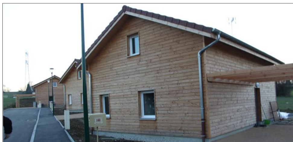
Quatre maisonnettes indépendantes, répondant à tous les critères de sécurité et d'accessibilité et des normes en vigueur liées aux économies d'énergies et à la protection de l'environnement, ont été réceptionnées. Elles disposent d'une petite dépendance et de parkings individuels.
