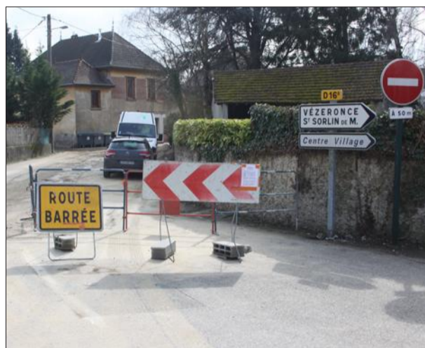
Un plan de circulation a été mis en place depuis la rue du Navan où d'importants travaux ont lieu actuellement. Ils vont durer pendant plusieurs mois.
